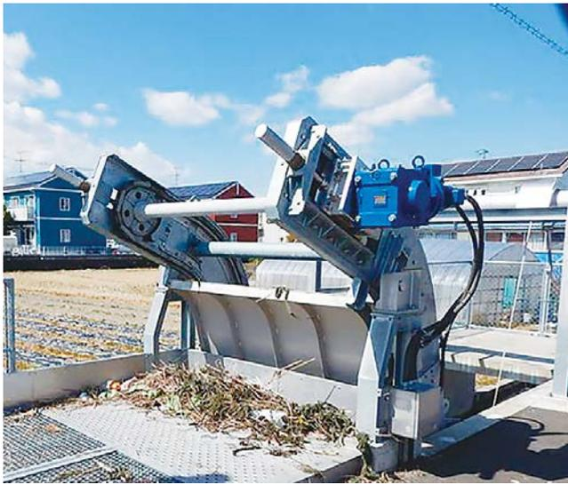
図5 除塵機のみ設置されている事例
