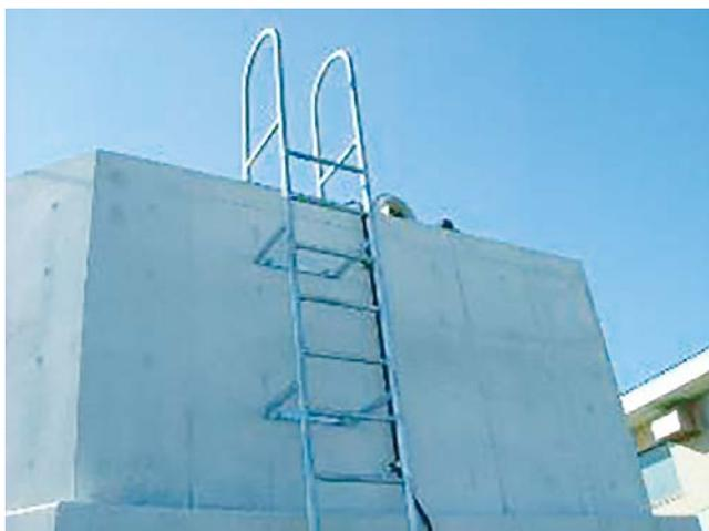
図1 吐出水槽天端に手すりがなく、昇降梯子に背かごが無い事例
