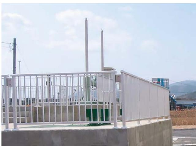
図2 吐出水槽天端に手すりがある事例
